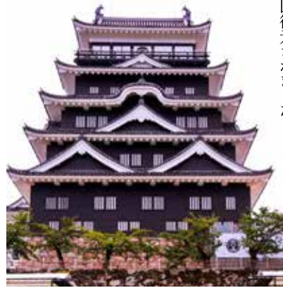
復元された天守北面の「鉄板張り」
